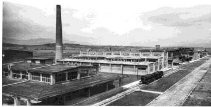
18. Pohľad z južnej strany na závod po jeho dokončení v roku 1940
